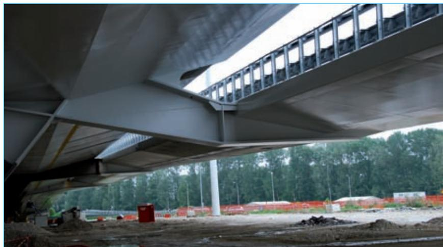
Figura 17. Unión de rampa de acceso con el tronco del viaducto. Puente de Padua.
