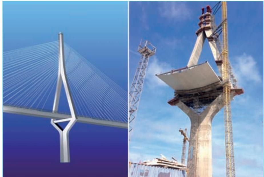
Figura 42. Tramo principal. Puente sobre la Bahía de Cádiz. Imagen virtual y construcción.
