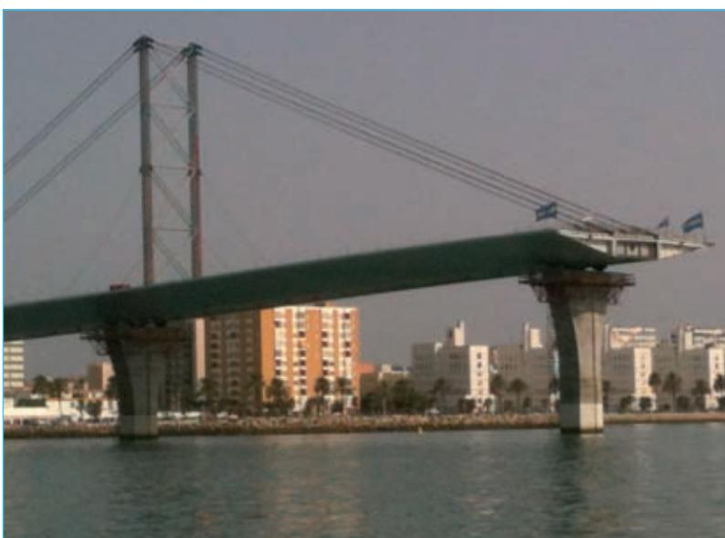
Figura 40. Construcción del Tramo Viaducto de acceso a Cádiz. Puente sobre la Bahía de Cádiz.
