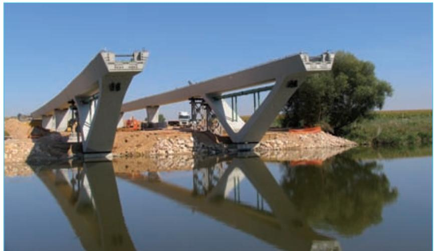
Figura 3. Puente sobre el río Duero en Zamora. Colocación del dintel sobre las pilas.
