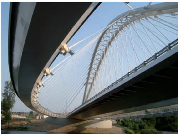
Figura 27. El puente sobre el río Ebro en Logroño tiene una luz de 140 m.
