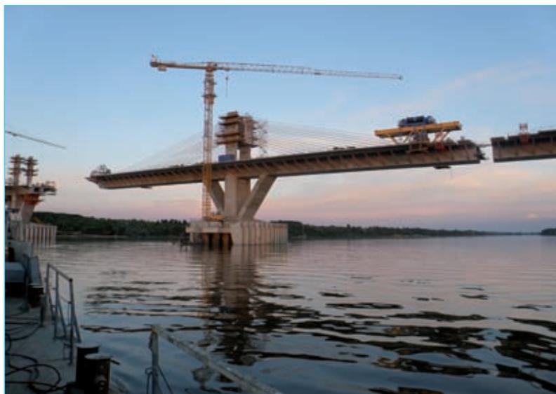
Figura 36. Construcción en avance en voladizo con dovelas prefabricadas.
