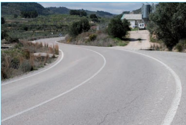
Foto 3. Alineación horizontal curvilínea continua.
