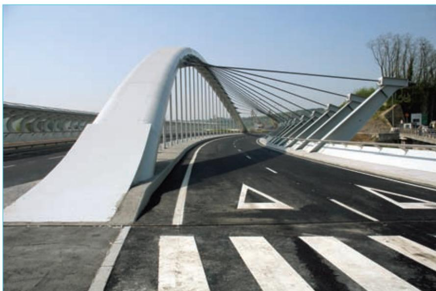
Figura 23. Arriostramiento transversal del arco.
